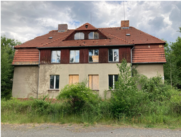
Werkssiedlung Heye III, Ansicht Arbeiterwohnhaus Fotograf/Urheber: Kathrin Kruner
