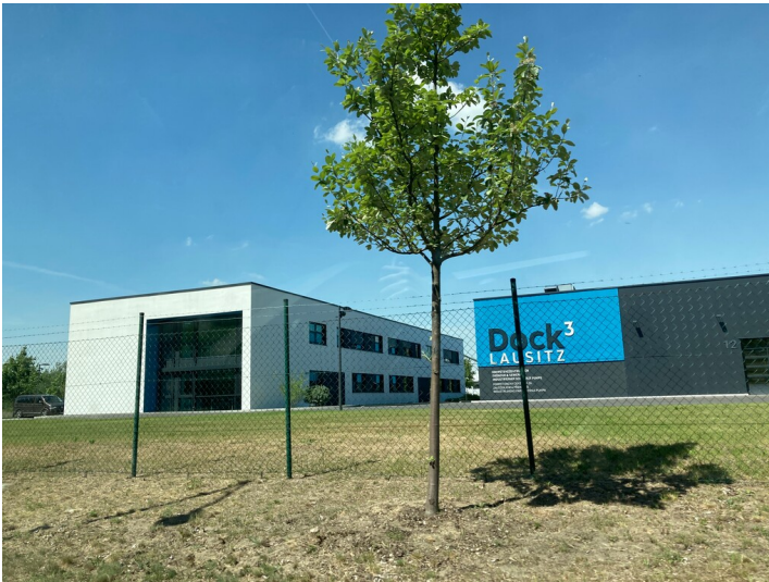
Dock3Lausitz, Straßenansicht von Süden Fotograf/Urheber: Kathrin Kruner
