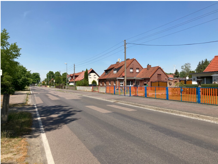
Arbeitersiedlung Spreewitz/Siedlung, Straßenansicht Fotograf/Urheber: Kathrin Kruner
