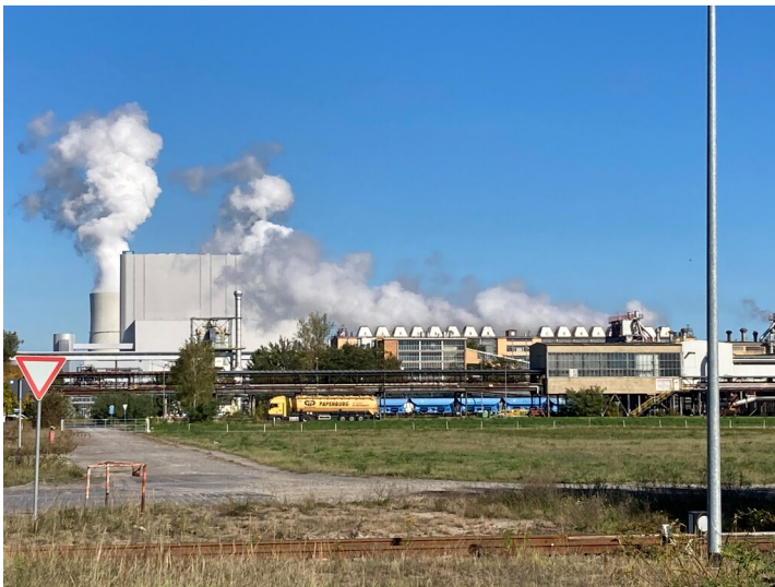
Industriepark Schwarze Pumpe Fotograf/Urheber: Tom Pfefferkorn
