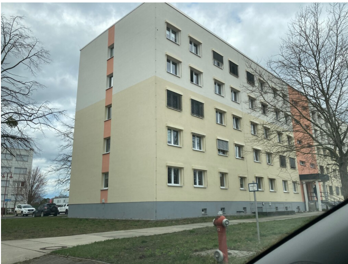
Bürogebäude der Tagesanlagen Welzow Fotograf/Urheber: Nora Wiedemann
