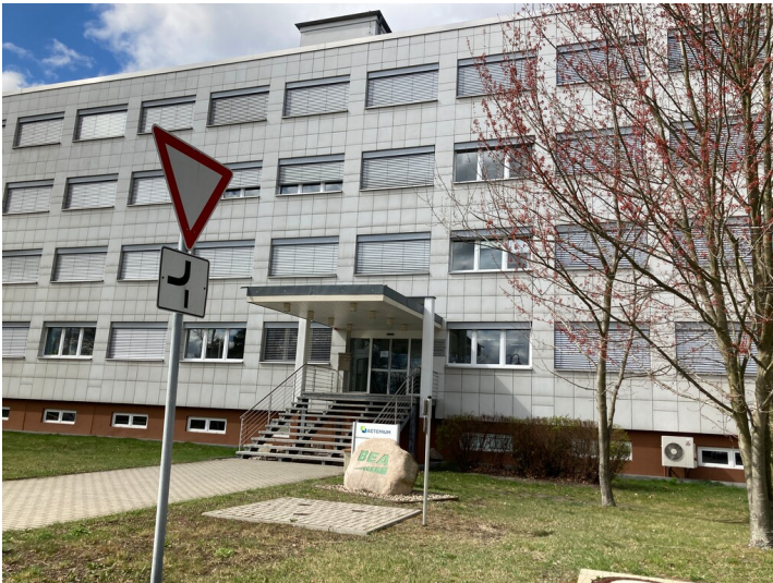
Bürogebäude Schwarze Pumpe, Ansicht von Nordosten Fotograf/Urheber: Kathrin Kruner
