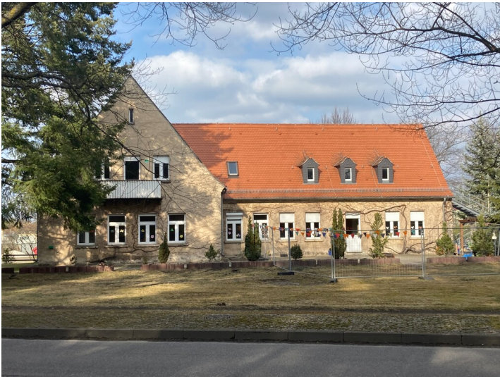
Kindergarten Lautawest, Ansicht von Südwesten Fotograf/Urheber: Tom Pfefferkorn
