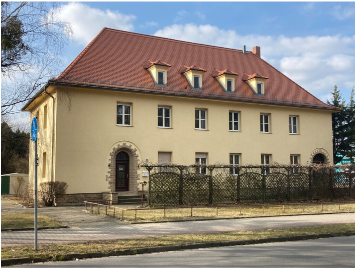
Ehemalige Sozialstation, Ansicht von Südosten Fotograf/Urheber: Tom Pfefferkorn
