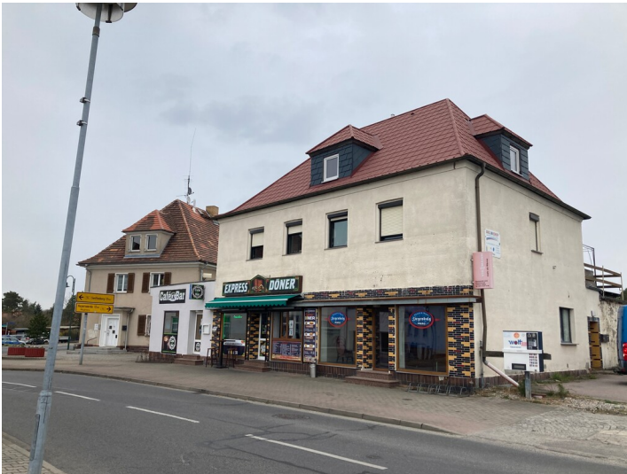
Wohnhaus mit Ladengeschäft in Lautawest, Ansicht von Westen Fotograf/Urheber: Kathrin Krüner
