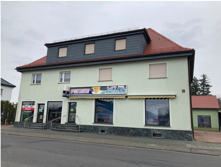
Wohnhaus mit Ladengeschäft in Lauta-West, Ansicht von Westen Fotograf/Urheber: Kathrin Kruner
