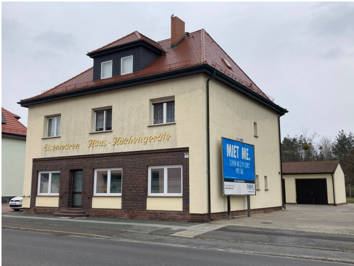
Wohnhaus mit Ladengeschäft, Ansicht von Westen Fotograf/Urheber: Kathrin Kruner
