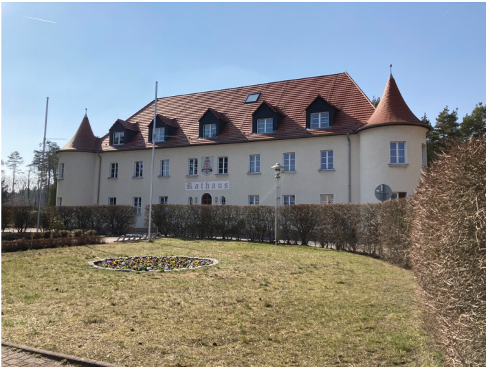
Rathaus Lauta, ehemaliges Altenheim, Ansicht von Osten Fotograf/Urheber: Kathrin Kruner
