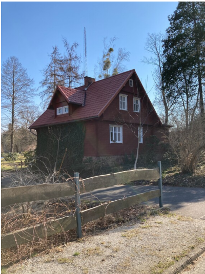
ehemaliges Forsthaus der Bergmannsheimstätten, Ansicht von Nordosten Fotograf/Urheber: Kathrin Kruner
