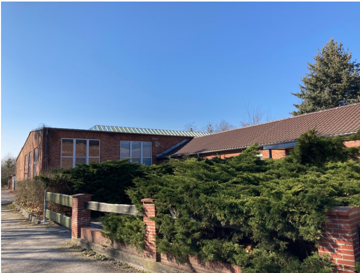
Gebäude der ehemaligen Lehrwerkstatt Brikettfabrik Erika-Laubusch Fotograf/Urheber: Kathrin Kruner
