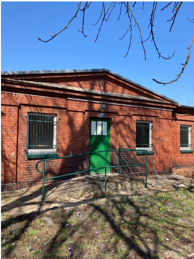
Bracken der ehemalige Brikettfabrik Erika-Laubusch, Außenansicht von Nordwesten Fotograf/Urheber: Kathrin Kruner
