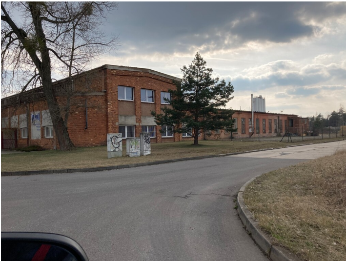
Lautawerk, ehemalige Elektrowerkstatt Fotograf/Urheber: Nora Wiedemann
