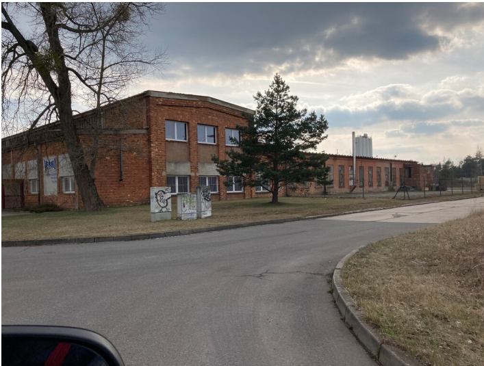
Lautawerk, ehemalige Elektrowerkstatt Fotograf/Urheber: Nora Wiedemann
