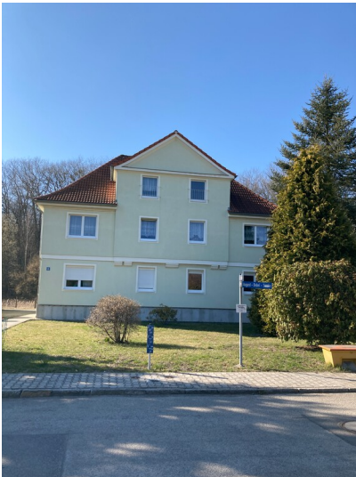
Arbeiterwohnhaus der Bergmannsheimstätten Laubusch, Ansicht von Nordosten Fotograf/Urheber: Kathrin Kruner
