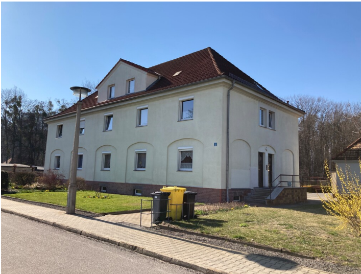
Arbeiterwohnhaus Bergmannsheimstätten Laubusch, Ansicht August-Bebel-Str. 2 von Osten Fotograf/Urheber: Kathrin Kruner
