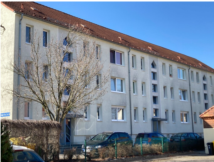
Wohnblock Bergmannsheimstätten Laubusch, Ansicht von Südosten Fotograf/Urheber: Kathrin Kruner
