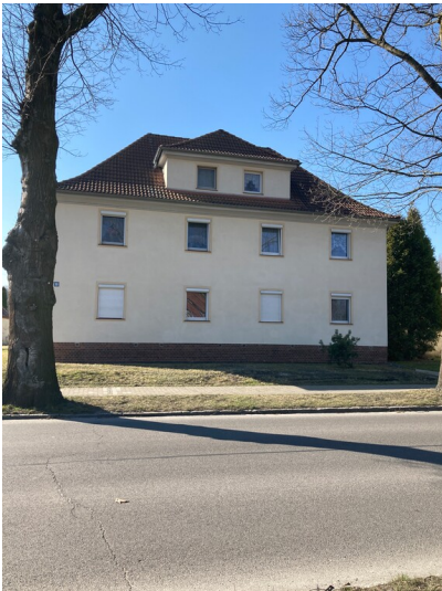
Arbeiterwohnhaus der Bergmannsheimstätten, Ansicht von Osten Fotograf/Urheber: Kathrin Kruner
