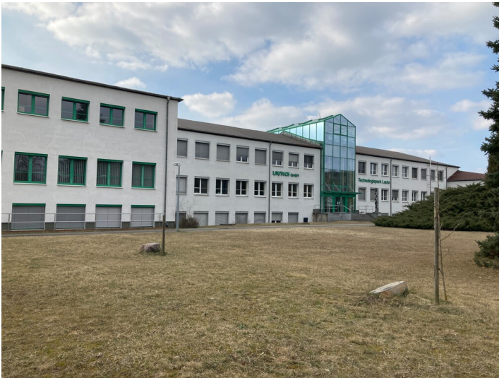
Ehemalige Lehrwerkstatt des Aluminiumwerkes Lauta, Ansicht von Osten Fotograf/Urheber: Kathrin Kruner
