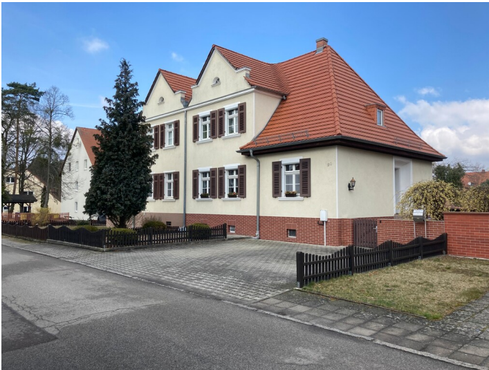
Beamtenwohnhaus der Gartenstadt Lauta-Nord, Straßenansicht Fotograf/Urheber: Kathrin Kruner
