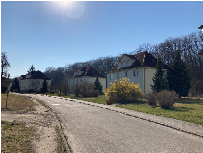
Siedlung Bergmannsheimstätten Fotograf/Urheber: Kathrin Kruner
