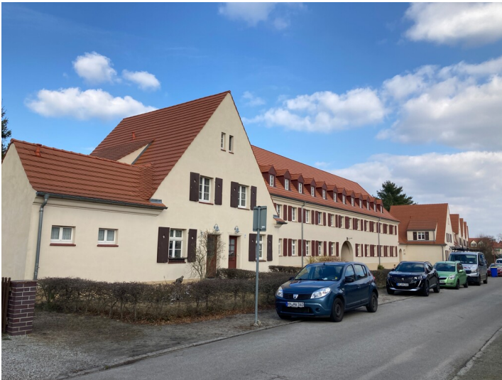
Arbeiterwohnhaus der Gartenstadt Lauta-Nord, Straßenansicht Fotograf/Urheber: Kathrin Kruner
