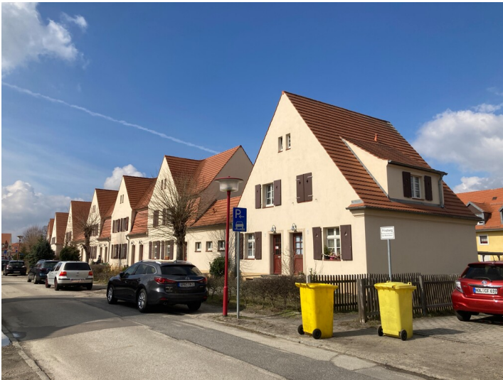
Arbeiterwohnhaus der Gartenstadt Lauta-Nord, Ansicht Wohnzeile Fotograf/Urheber: Kathrin Kruner
