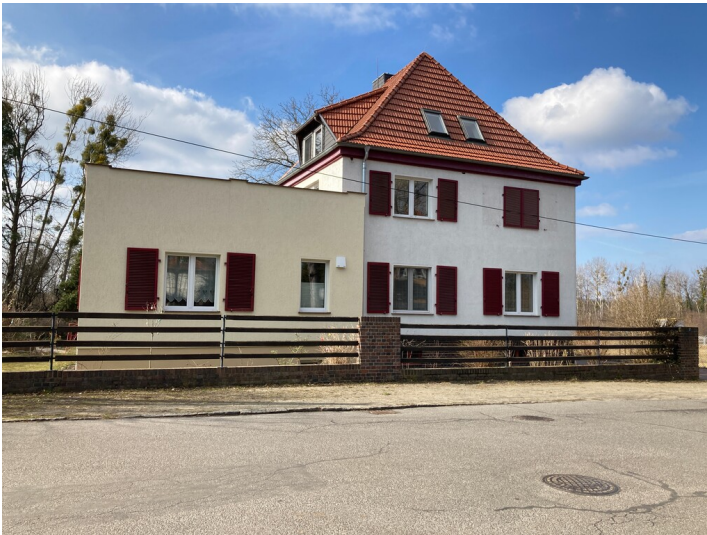
Wohnhaus der Gartenstadt Lauta-Nord, Ansicht von Osten Fotograf/Urheber: Kathrin Kruner
