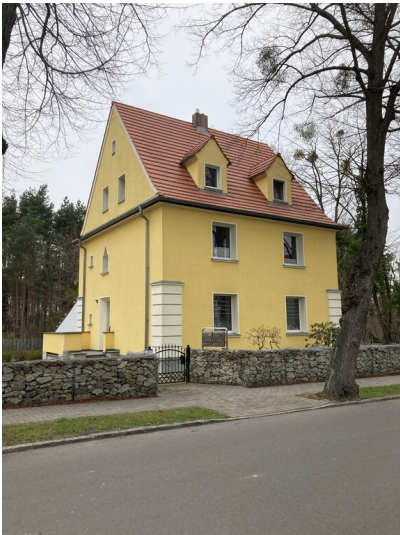
Wohnhaus der Gartenstadt Lauta-Nord, Ansicht von Osten Fotograf/Urheber: Kathrin Kruner
