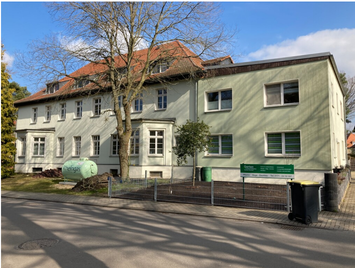
Beamtenwohnhaus der Gartenstadt Lauta-Nord, Ansicht von Westen Fotograf/Urheber: Kathrin Kruner
