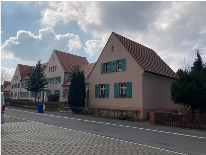
Arbeiterwohnhaus der Gartenstadt Lauta-Nord, Ansicht von Nordosten Fotograf/Urheber: Kathrin Kruner
