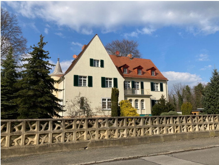
Beamtenwohnhaus Gartenstadt Lauta-Nord, Straßenansicht von Südwesten Fotograf/Urheber: Kathrin Kruner
