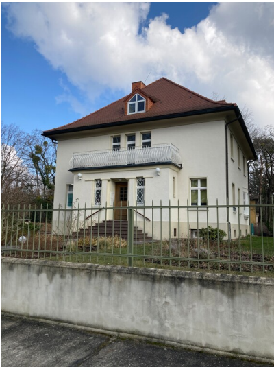
Villa Gartenstadt Lauta-Nord, Straßenansicht von Südosten Fotograf/Urheber: Kathrin Kruner
