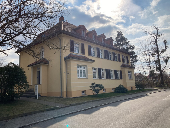
Beamtenwohnhaus Gartenstadt Lauta-Nord, Straßenansicht von Westen Fotograf/Urheber: Kathrin Kruner
