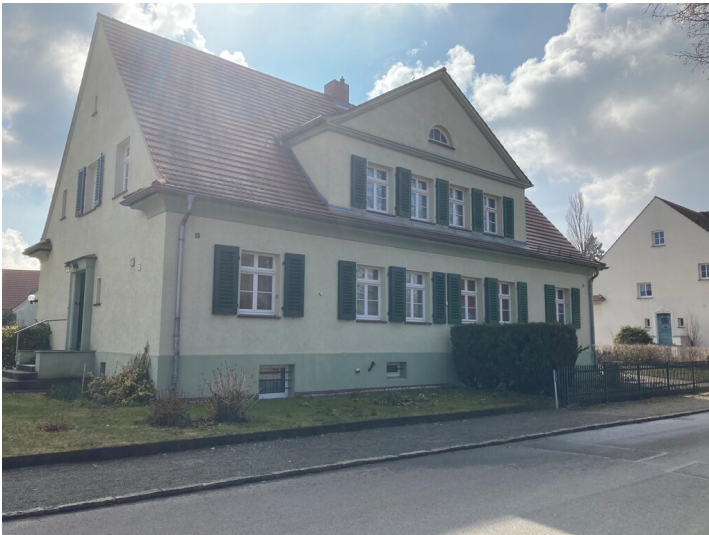
Beamtenwohnhaus Gartenstadt Lauta-Nord, Nordstraße 13/15, Ansicht von Nordosten Fotograf/Urheber: Kathrin Kruner
