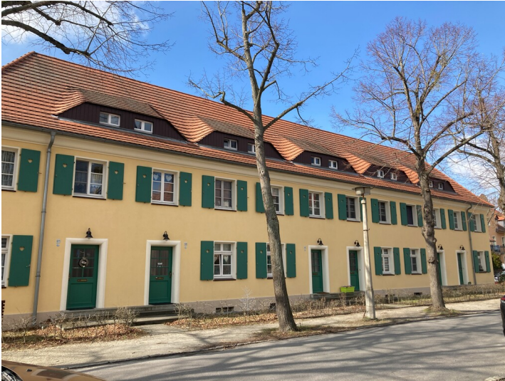
Arbeiterwohnhaus Gartenstadt Lauta-Nord, Straßenansicht von Süden Fotograf/Urheber: Kathrin Kruner
