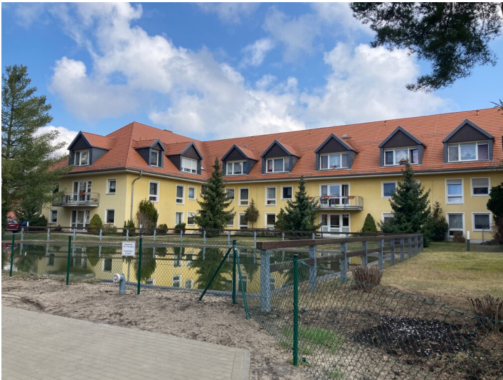
Beamtenledigenheim der Gartenstadt Lauta-Nord, Ansicht von der Schulstraße aus Westen Fotograf/Urheber: Kathrin Kruner
