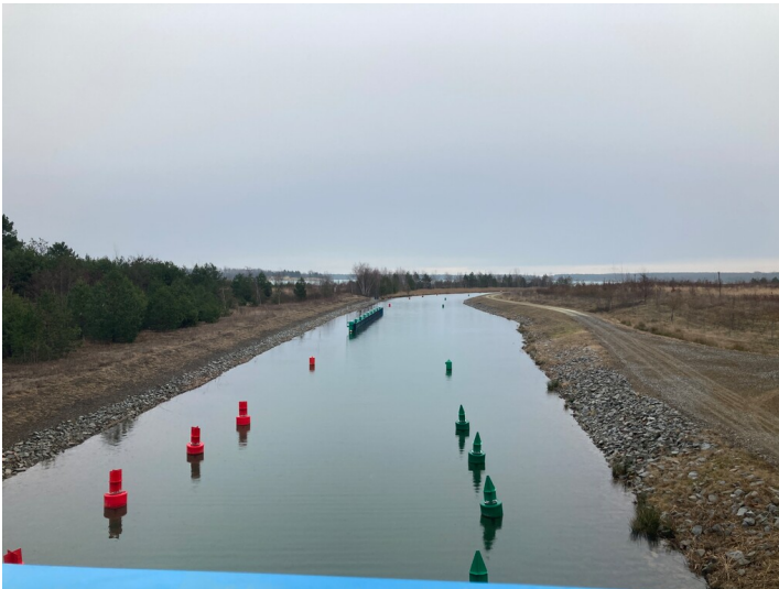
Koschendamm mit Barbarakanal, Ansicht von Osten Fotograf/Urheber: Kathrin Kruner
