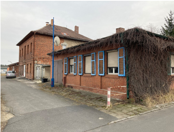
Barackenstadt Lautasüd, Verwaltungsgebäude, Ansicht von Nordosten Fotograf/Urheber: Tom Pfefferkorn
