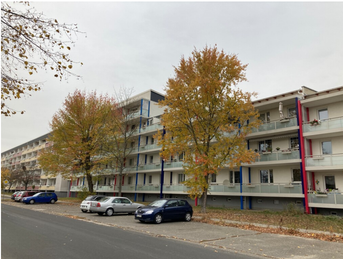
Wohnkomplex Prof.-Wagenfeld-Ring, Ansicht Wohnblock 59 bis 62 Fotograf/Urheber: Kathrin Kruner
