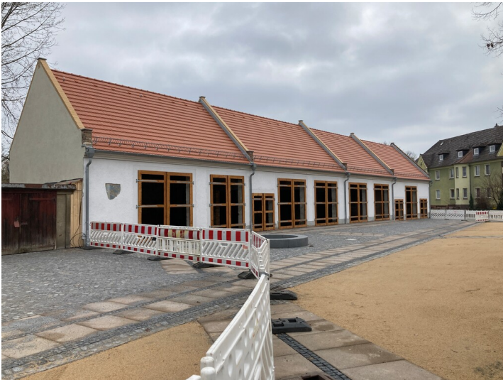
Stadtscheunen des Alunwerkes Bad Muskau, Ansicht von Westen Fotograf/Urheber: Kathrin Kruner
