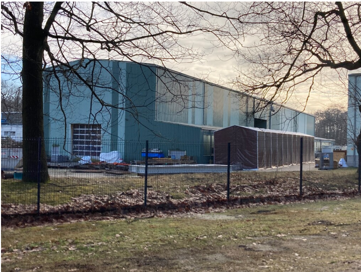
Produktionsanlagen Entstaubungstechnik, Ansicht von Süden Fotograf/Urheber: Tom Pfefferkorn
