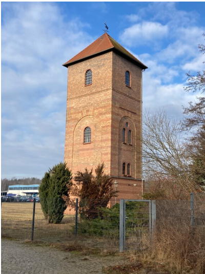
Wasserturm ("Barbaraturm") der Keulahütte, Ansicht von Norden Fotograf/Urheber: Kathrin Kruner
