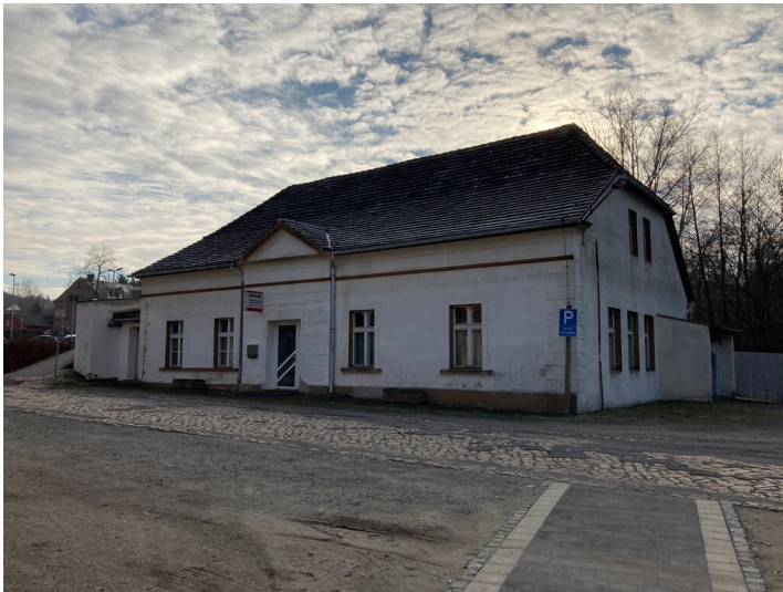
Nebengebäude der Keulahütte, Ansicht von Westen Fotograf/Urheber: Kathrin Krüner
