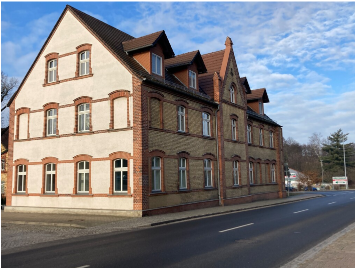
Ehemaliges Kontorgebäude der Keulahütte, Ansicht von Südosten Fotograf/Urheber: Kathrin Kruner
