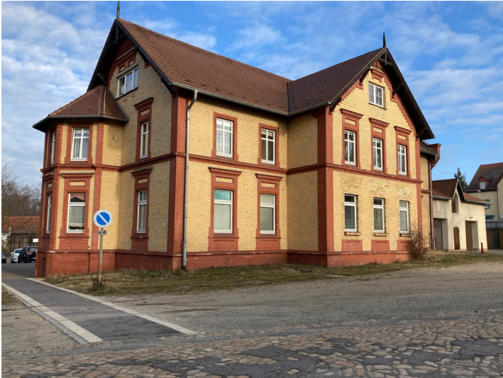
ehemaliges Verwaltungsgebäude der Keulahütte, Ansicht von Südwesten Fotograf/Urheber: Kathrin Kruner
