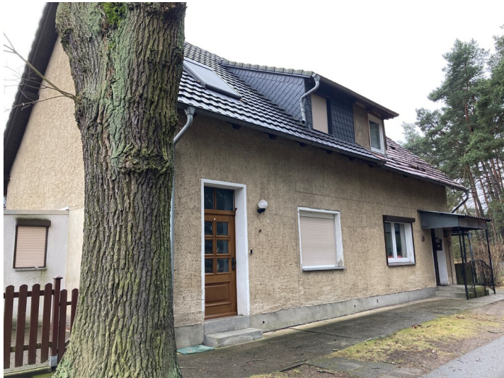
Einfamilienwohnhaus der Bergarbeitersiedlung "Kolonie Pechern", Ansicht von Nordosten Fotograf/Urheber: Kathrin Kruner
