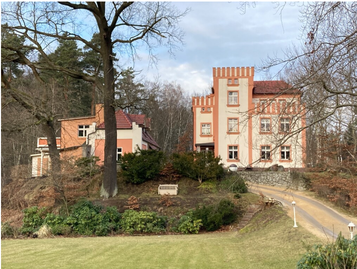
Ehemalige Beamtenwohnhaus einer Ziegelei, Ansicht von Süden Fotograf/Urheber: Kathrin Kruner
