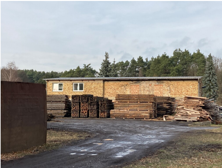
Ehemaligen Produktionsgebäude der Ziegelei, Ansicht von Südwesten Fotograf/Urheber: Kathrin Kruner
