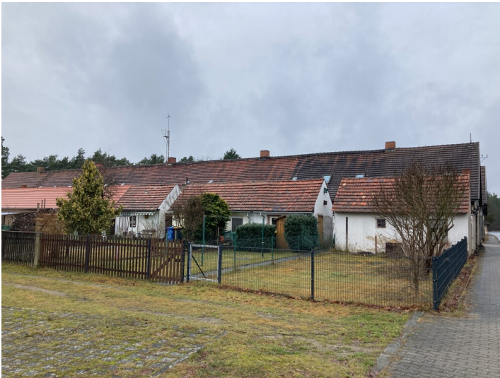
Bergarbeitersiedlung "Colonie Pechern", Ansicht von Westen Fotograf/Urheber: Kathrin Kruner
