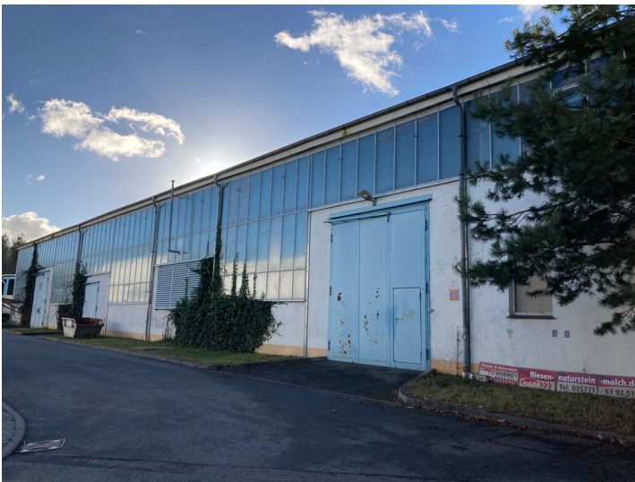
Produktionsgebäude VEB Wissenschaftlich-technisches Werk Bad Muskau, Ansicht von Norden Fotograf/Urheber: Kathrin Kruner
