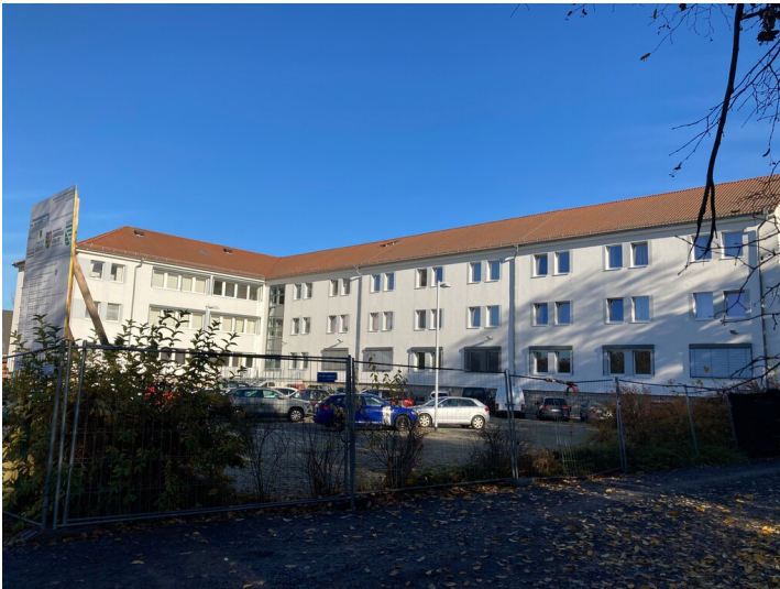
Berufsschule "Reinhold Greiner", Ansicht von Südwesten Fotograf/Urheber: Kathrin Kruner
